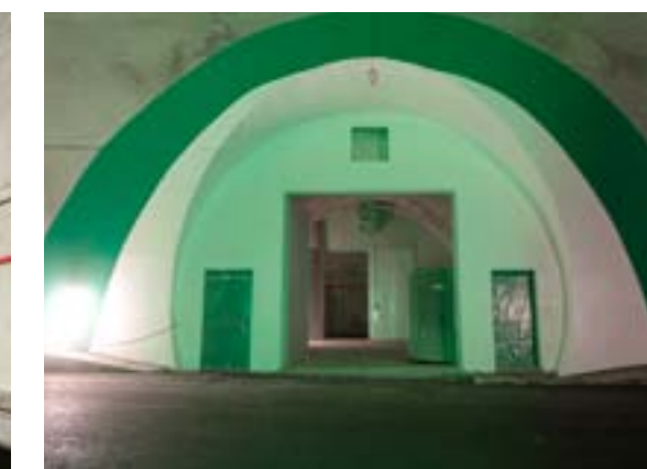
Galeria de emergência
