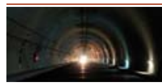
O maior Túnel da Península Ibérica
