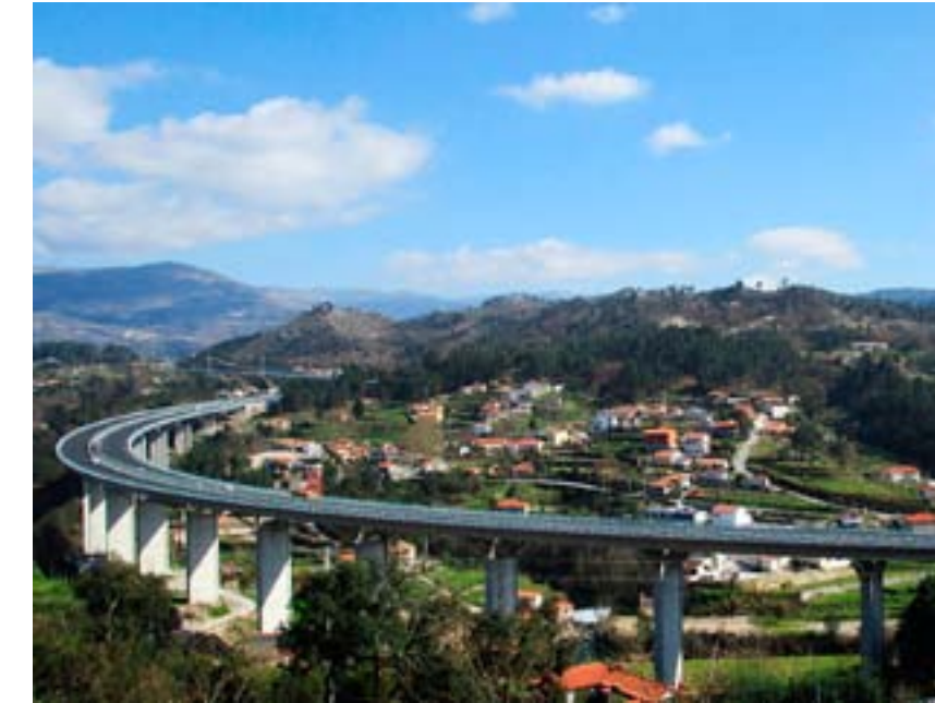
Viaduto V1 – Viaduto sobre o rio Ovelha
