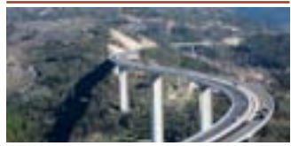
V3 - viaduto sobre o rio Marão, o mais extenso e o mais alto do lanço
