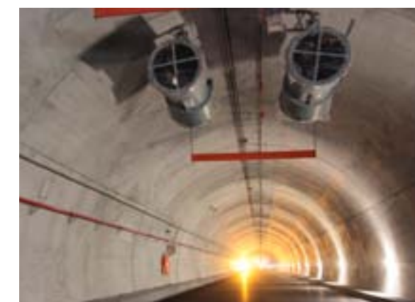
Sistema de ventilação
