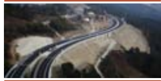
M40 e M41A - a maior extensão de aterro de solo-cimento do lanço
